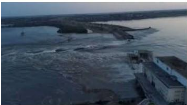
破壊されたカホフカダム
