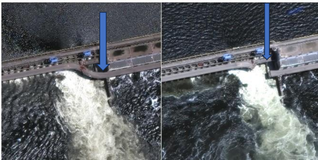
左は5月28日撮影の画像で、車道は損傷していない。右は6月5日撮影の画像で、車道に欠けた部分が見られる。
