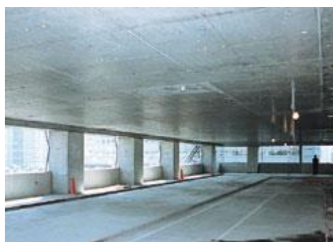
芝パークタワー 2001年 柱・梁のない居住空間 (間仕切りの変更自由)
